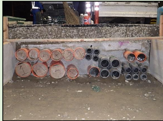
【福岡3号千早・名島地区無電柱化10工区工事】
